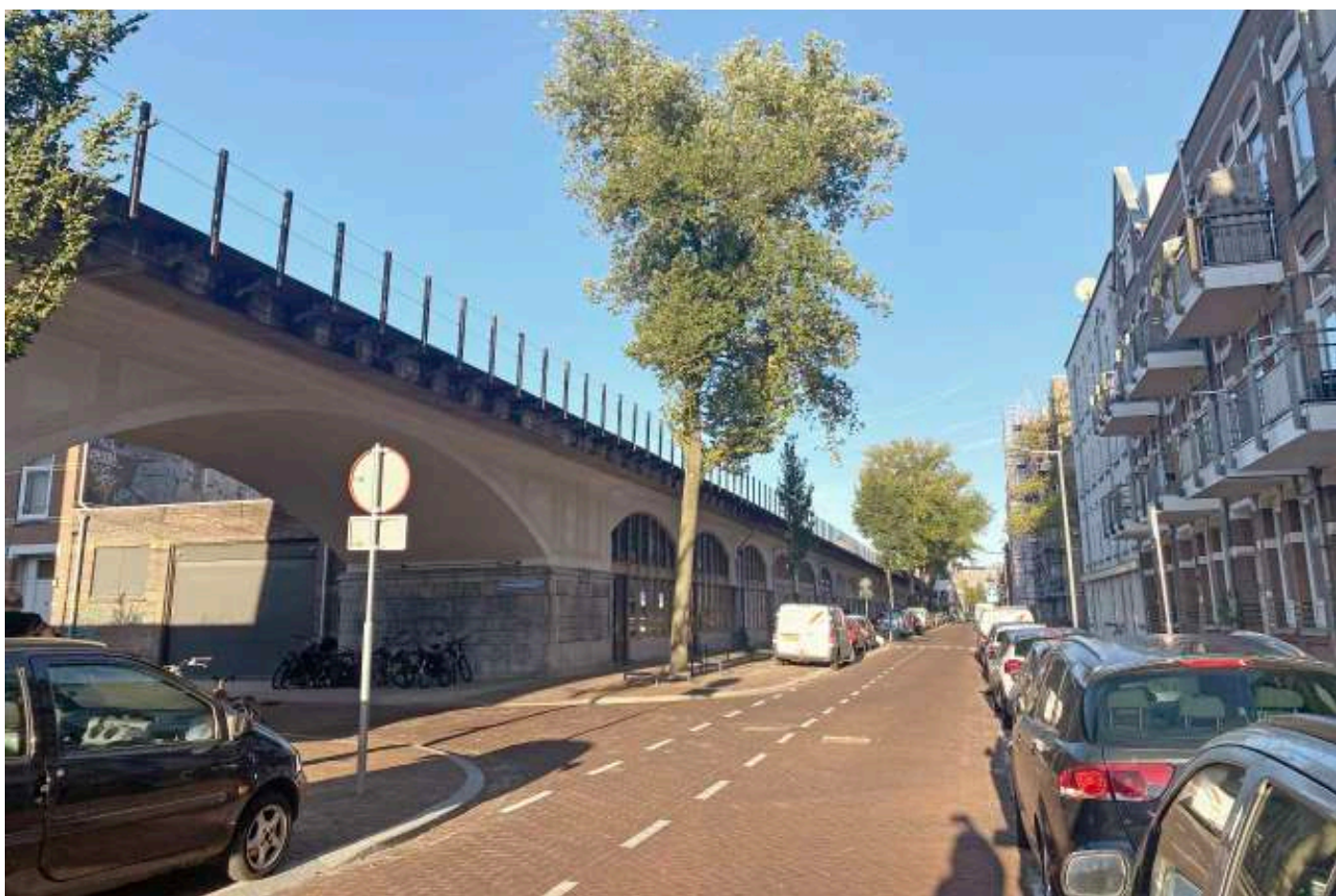
27 Huidige situatie: straatbeeld in het noordelijk deel. Bergpolder
