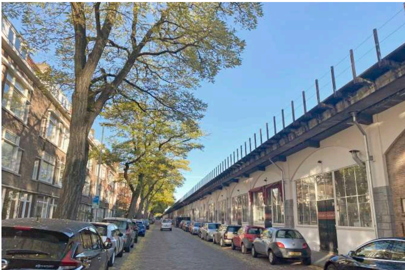
26 Huidige situatie: straatbeeld in het noordelijk deel. Bergpolder
