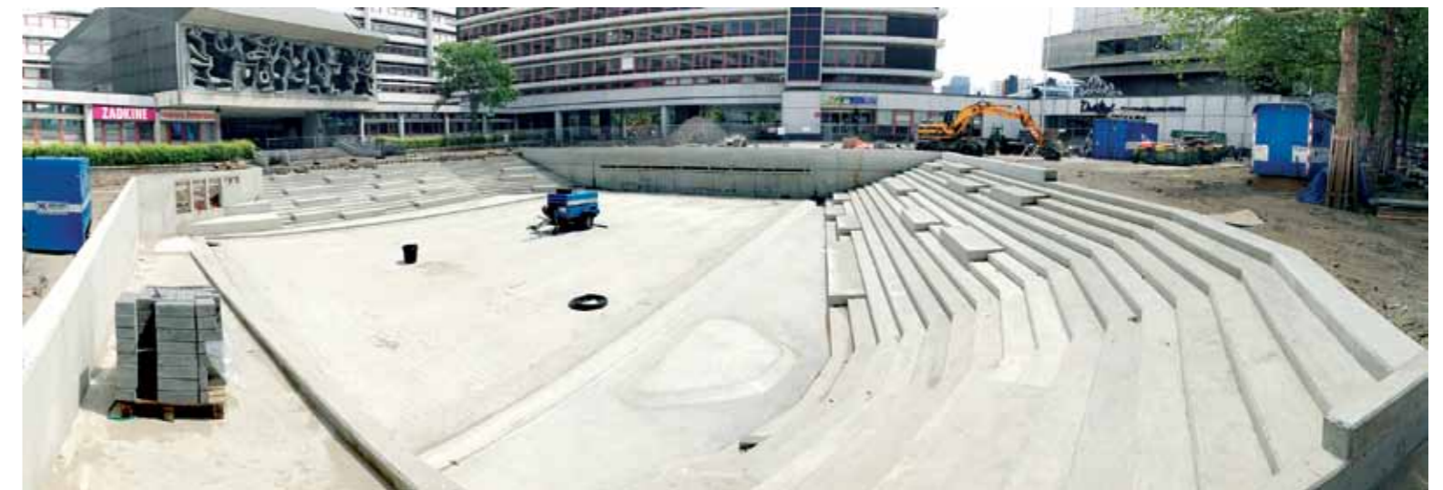
Het waterplein in aanleg. Uit de brede uitsparing stroomt bij hevige regenval het verdiepte plein vol.
